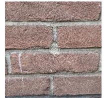
Gevel met gevoegde open stootvoeg
