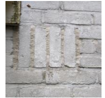
Gevel met gevoegde open stootvoeg
