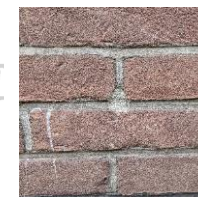
Gevel met gevoegde open stootvoeg
