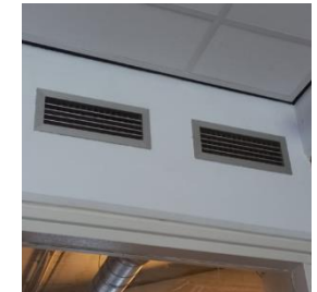
Mechanische ventilatieroosters
