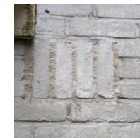
Gevel met gevoegde open stootvoeg
